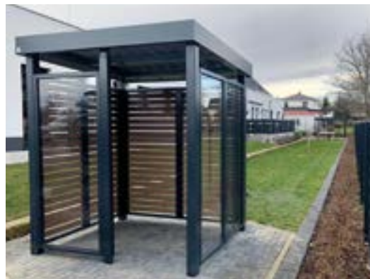
Stolper og rammer i rustfrit stål lakeret antracitgrå med vægge i plexiglas og lammeller i ubehandlet lærketræ.
