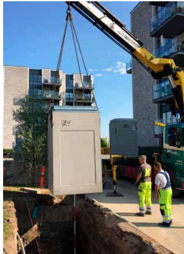
Betoncontaineren placeres i det klargjorte hul.
